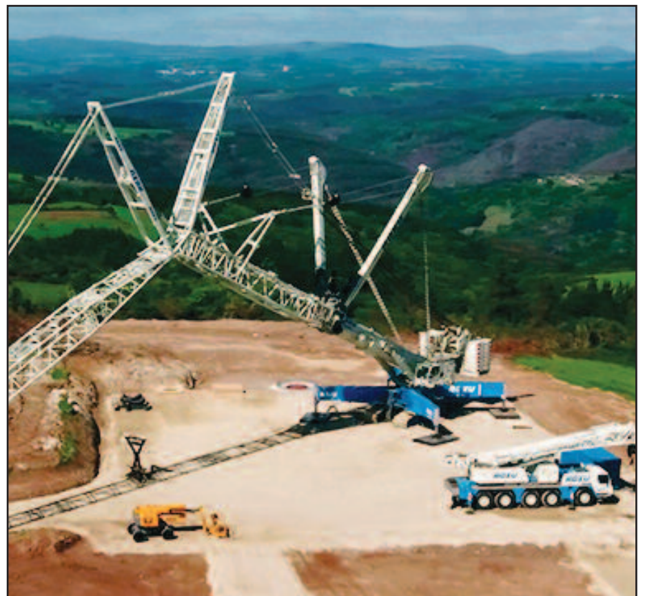
Obras de Endesa para construír o parque eólico en Paradela
