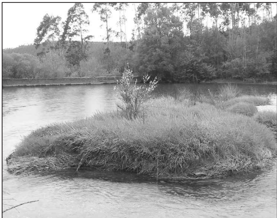
A balsa con cinco hectáreas de lodos tóxicos de San Fins está contida unicamente por un deteriorado encoro de formigón con máis de un século de antigüidade
